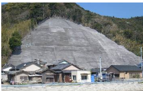
宮崎浦地区急傾斜地自然災害防止工事
