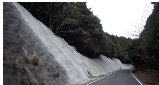
主要地方道有川奈良尾線道路災害防除工事
