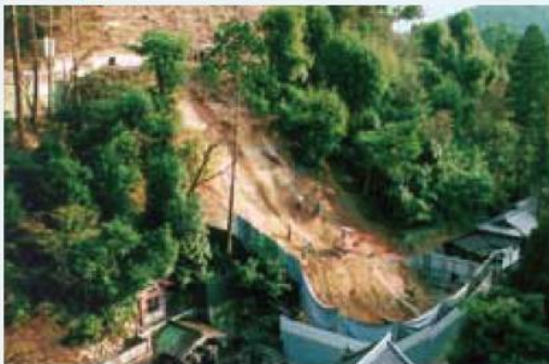
豪雨による崩壊斜面
