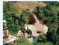
植生工施工状況(施工中)
