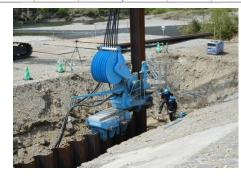
施工状況写真←↑ 延岡北川川坂地区 漏水対策工事 ハット型鋼矢板硬質地盤クリア工法
