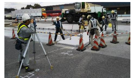
九州自動車道古賀SA施工状況
