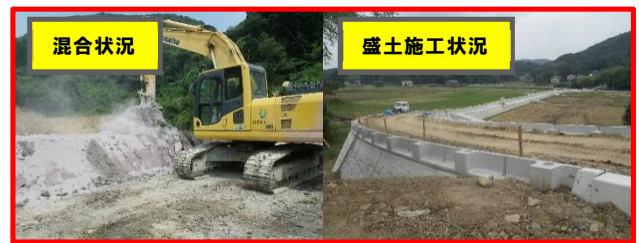
稗の坂線外1道路改良工事(盛土材)
