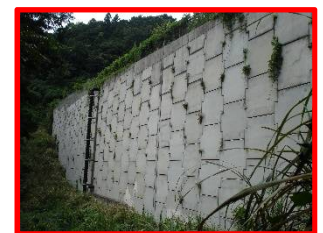
補強土壁工の基礎(長崎県)
